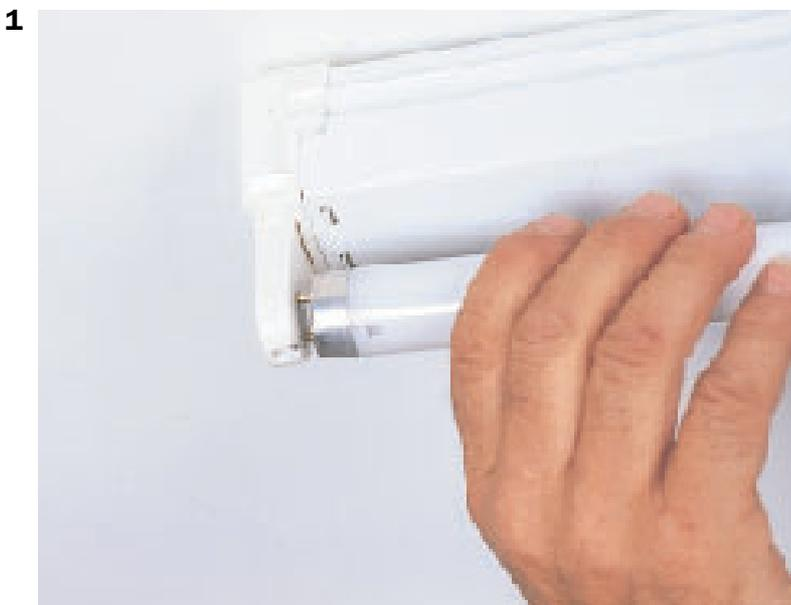
1. Avec les deux mains, faire tourner le tube d'un quart de tour. Les deux tétons du tube font tourner la douille.
